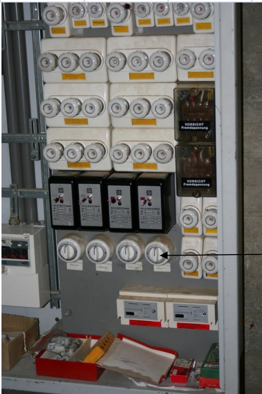
Boilerheizungsschalter
