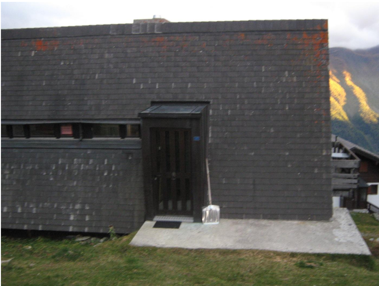
Eingang in die Wohnung
