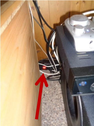
Hauptschalter muss rot leuchten.
